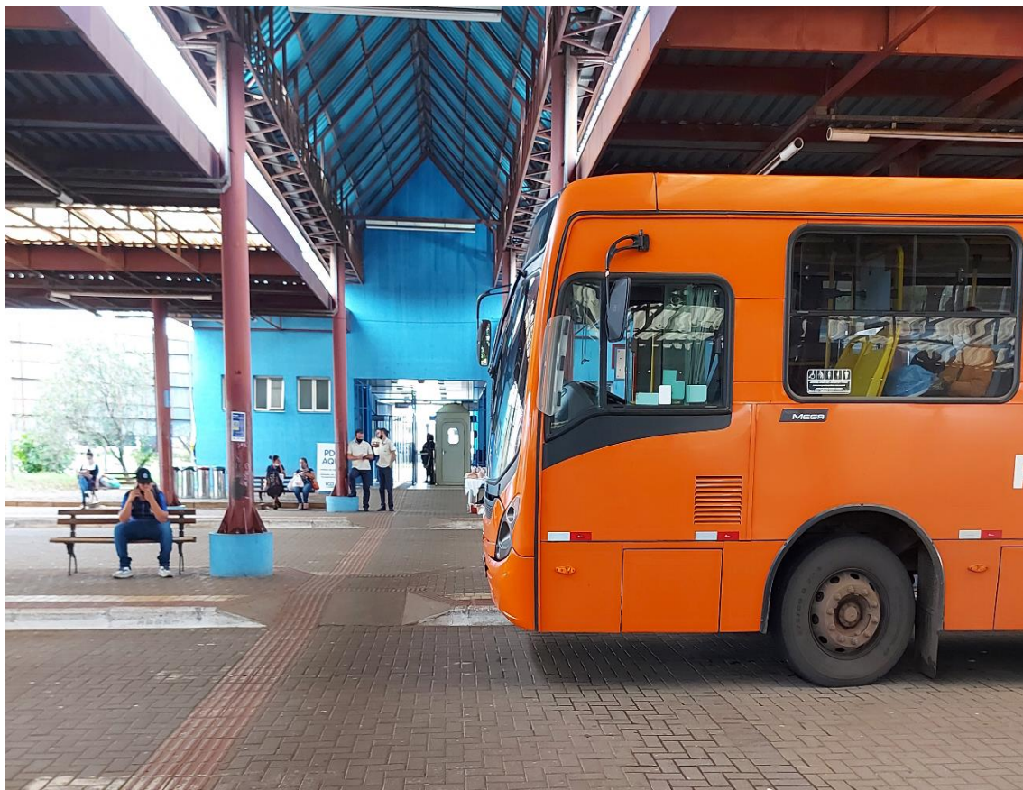
Figura 15 - Cobertura de Terminal na área de Embarque
