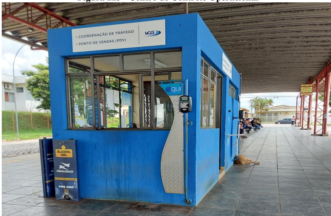
Figura 213 - Centro de Controle Operacional
