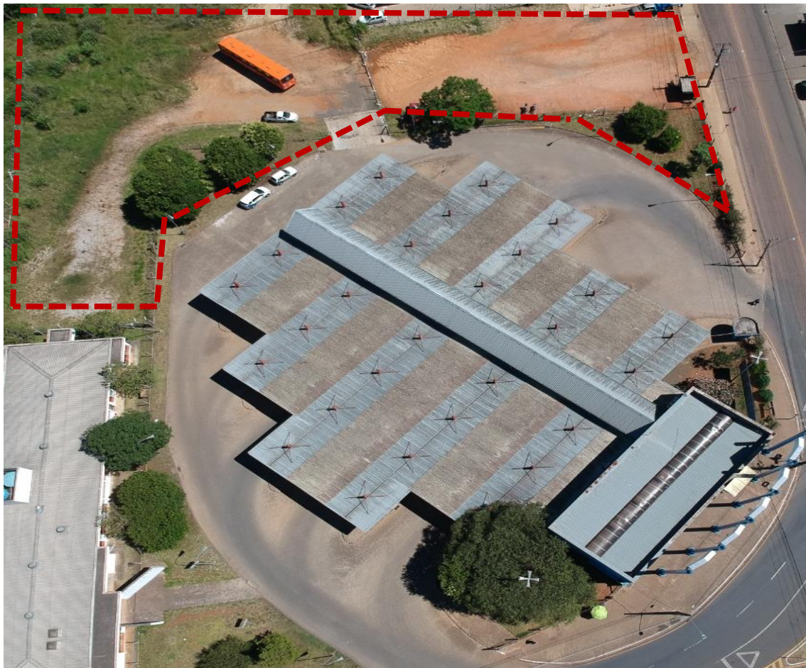
Figura 188 - Área disponível para expansão do Terminal Uvaranas
