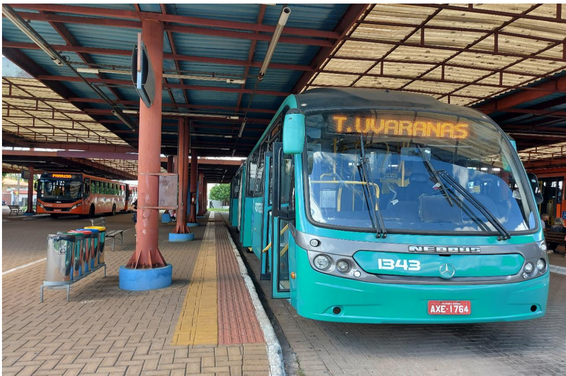
Figura 10 - Área de embarque no terminal
